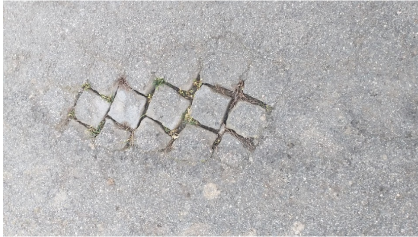
Abb. 4 Vorhandene Befestigung der „Pariser Straße“
