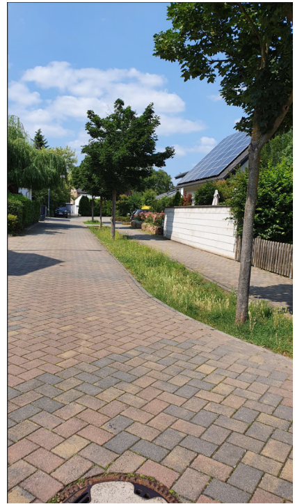
Abb. 20: Beispiel zur Gestaltung von Verkehrsflächen mit Mulden-Rigolen-Elementen (Foto Dillig Ing.)
